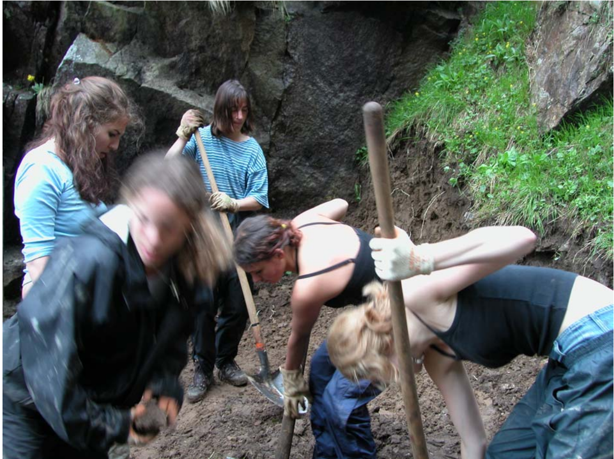
Während dem Einsatz: Arbeit am Vorplatz vor dem Jägerstollen. Räumen, ausebnen, sichern.
