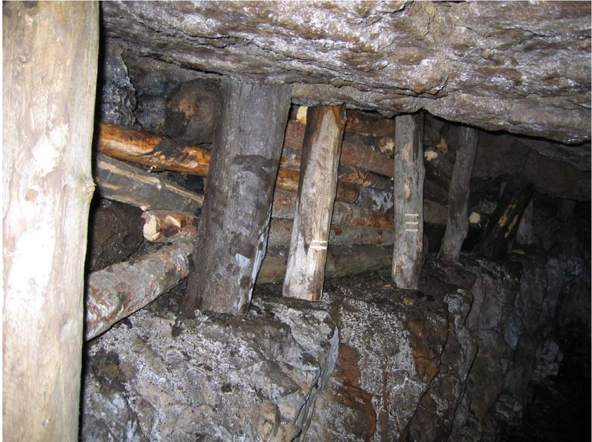
Nach dem Einsatz: Gesicherter Bereich mit lokal gewachsenem Holz.
